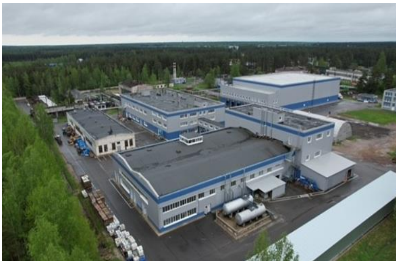
Территория Лужского химического завода
